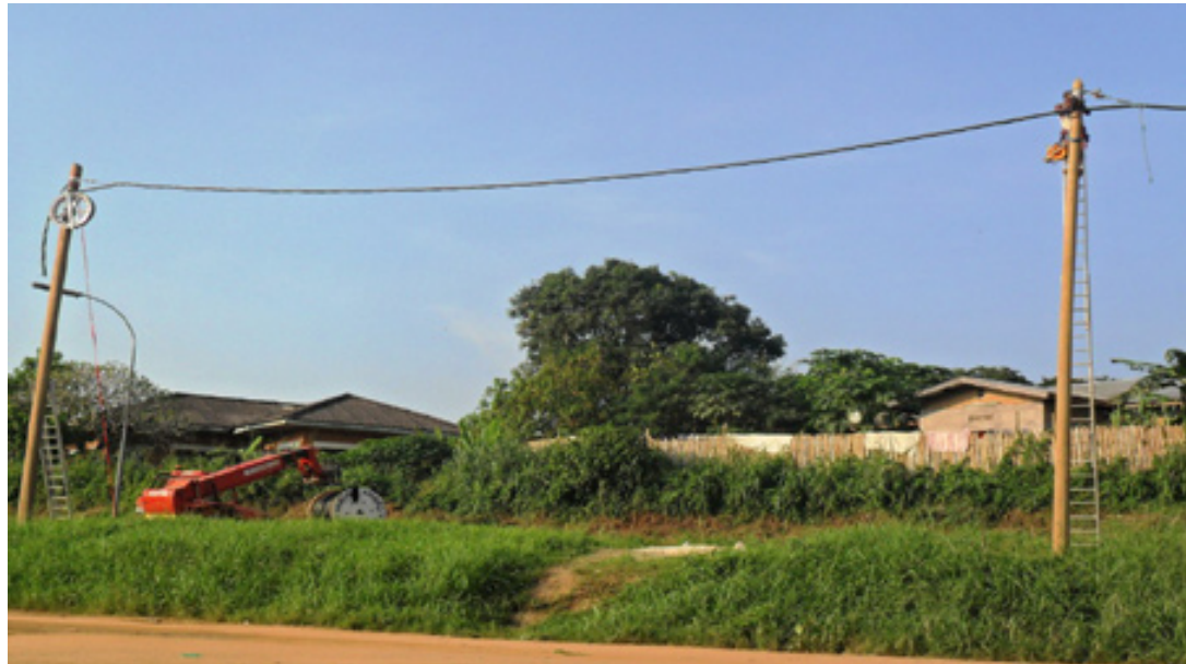
Remplacement des câbles électrique par le projet Afek devant la faculté des sciences © Mongongo
