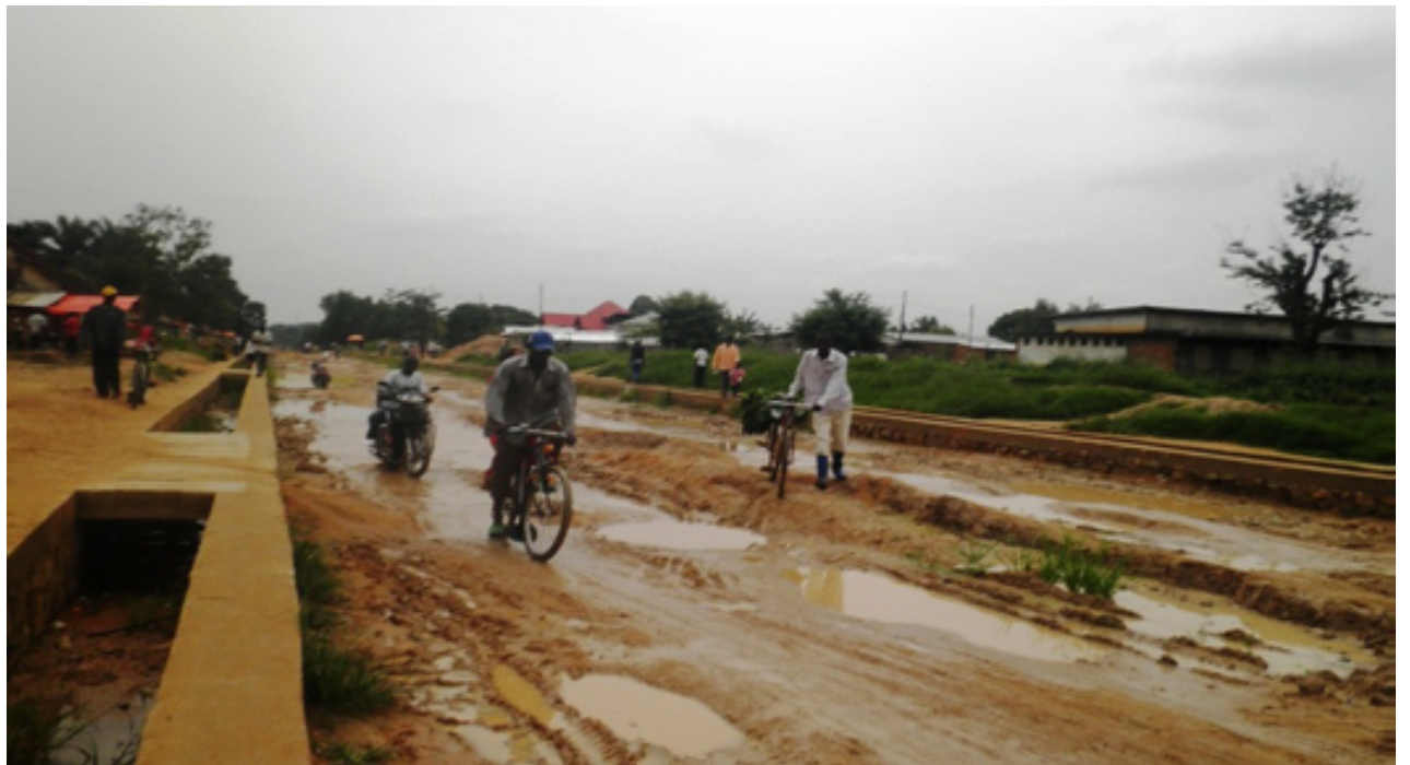
Une route boueuse qui attend d'être asphaltée entre le collège Maele et le pont Tshopo © Mongongo
